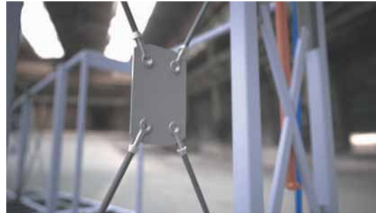
〈그림 2〉 모듈의 구조 보강재 시스템의 클로즈업 렌더링
